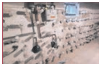
HORIZONTALSPERRE und Flächensperre.
