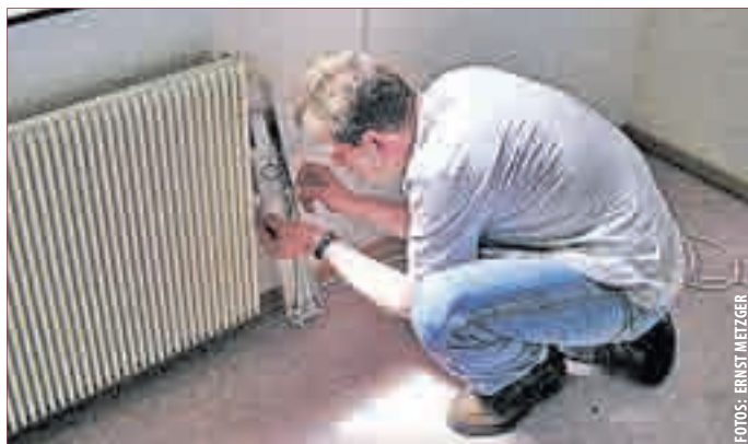
DIE MONTAGE VOR ORT: Innerhalb eines Tages ohne Baustelle installiert.
