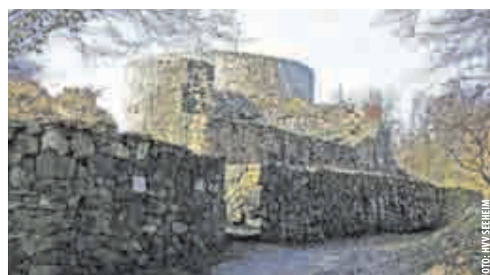
DER BAUBEGINN für die Begeharmachung des Turms wird im nächsten Frühjahr starten.
