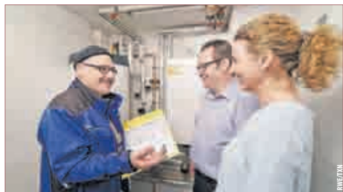
DIE ALTE HEIZUNG kostengünstig austauschen: Der Energieversorger übernimmt die kompletten Kosten für den Einbau eines neuen Gas-Brennwertkessels und bekommt dafür dann eine kalkulierbare monatliche Pauschale.
