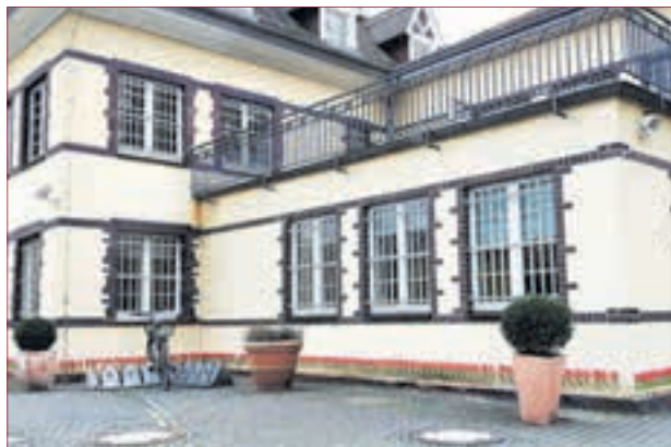
HORIZONTALSPERRE gegen aufsteigende Feuchtigkeit im Gebäude.
