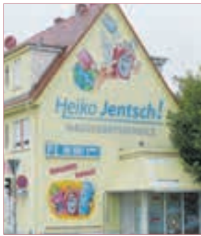
GESCHÄFT wird durch die auffällige Fassade kaum übersehen!
