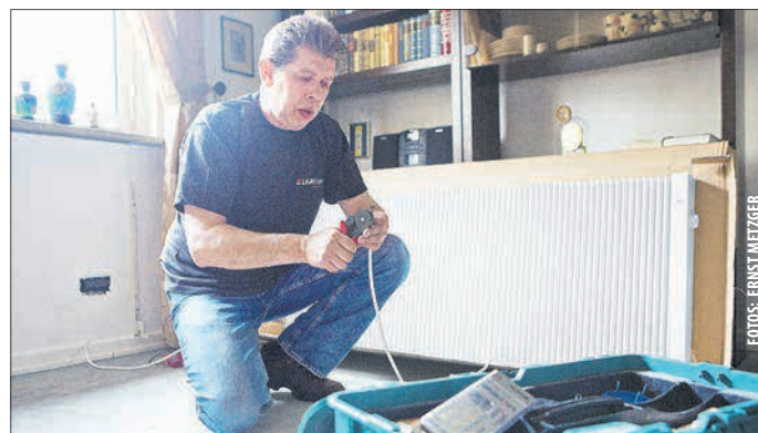
ERNST METZGER: „Montage vor Ort innerhalb nur einem Tag ohne Baustelle!“
