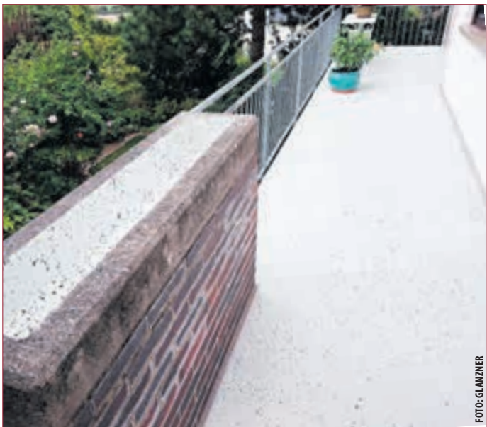
EIN TOP SANIERTER BALKON nach der bewährten Glanzner-Methode.
