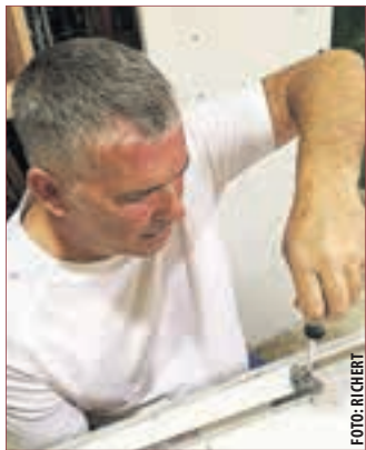
ALEXANDER RICHERT bei der Reparatur einer Stahlschranktür.
