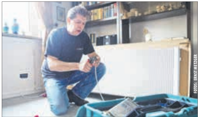
Ernst Metzger: „Montage vor Ort innerhalb nur einem Tag ohne Baustelle!“
