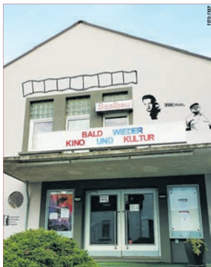
DIE ZUKUNFT IST GESICHERT dank großzügiger Spende. Die Renovierungsarbeiten sind beendet, jetzt kann die Eröffnung kommen.
