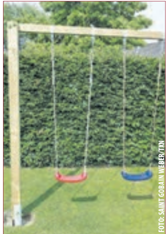
EINE SCHAUKELEINBAU: EINE SCHAUKELEINBAU. Und auch der scheinbar aufwendigste Teil, das Einbetonieren der Pfosten, ist mit einem Schnellbeton (nomix) aus dem Baumarkt einfach und problemlos zu realisieren.
