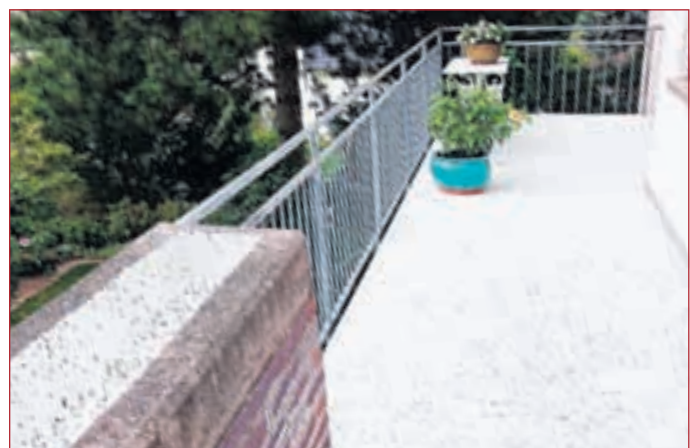
TOP SANIERTER BALKON nach Glanzner-Methode.
