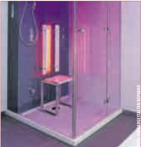
EINE DAMPFKABINE MIT INFRAROTSTRAHLER - es gibt heute viele Möglichkeiten, kleine Badezimmer in einen Spa-Bereich zu verwandeln.
