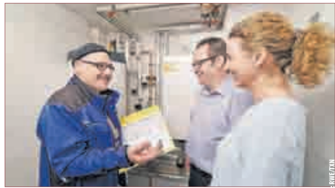
DIE ALTE HEIZUNG kostengünstig austauschen: Der Energieversorger übernimmt die kompletten Kosten für den Einbau eines neuen Gas-Brennwertkessels und bekommt dafür dann eine kalkulierbare monatliche Pauschale.
