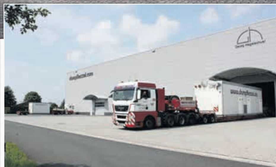
AUF DEM 9.000 QM GROSSEN GRUNDSTÜCK befindet sich eine neue 3.000qm große Halle (vorher 1.000qm), sowie ein 1.000qm großer Büro- und Lagertrakt (Foto oben). KESSEL UND BRENNER werden hier von namenhaften Marken wie Bosch, Vissmann und Weißhaupt verbaut (Foto links).
