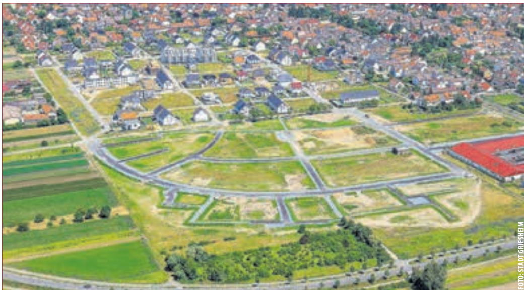
WOHNGEbiet SÜDWEST: Das Foto zeigt das Wohngebiet „Südwest“ aus Richtung Süden mit den östlich gelegenen Märkten.
