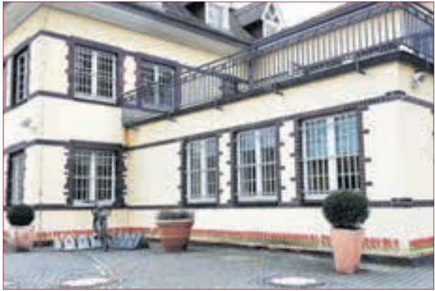
HORIZONTALSPERRE gegen aufsteigende Feuchtigkeit im Gebäude.
