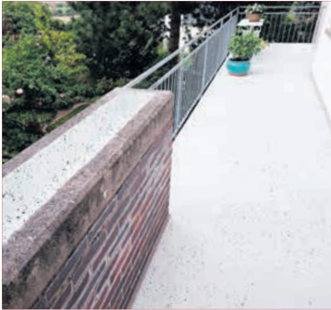
TOP SANIERTER BALKON nach Glanzner-Methode.
