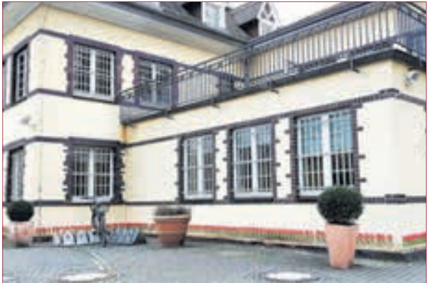
HORIZONTALSPERRE gegen aufsteigende Feuchtigkeit im Gebäude.
