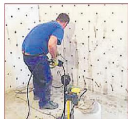
FLÄCHENSPERRE: Die Wände werden trocken, bleiben garantiert atmungsaktiv und das Mauerwerk erhält seine natürliche Fähigkeit zur Wärmedämmung zurück.
