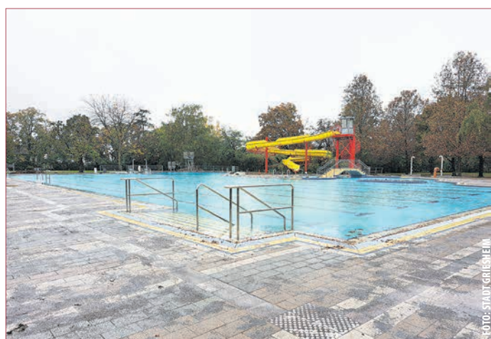
FLIESEN- UND PFLASTERARBEITEN in beiden Becken sind abgeschlossen.
