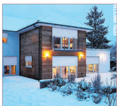
ANGENEHME RAUMTEMPERATUREN und frische Luft das ganze Jahr über: Wenn motorisierte Fenster und Rollläden sowie passende Sensoren per Funk ins Smart Home eingebunden werden, lebt es sich unterm Strich komfortabler, gesünder und günstiger. (tm)
