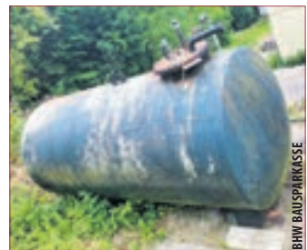
ALTE ÖLTANKS bieten viele neue Speicherkapazitäten.
