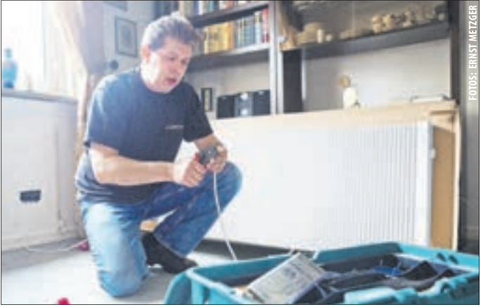
E. METZGER: „Montage vor Ort innerhalb nur 1 Tag ohne Baustelle!“
