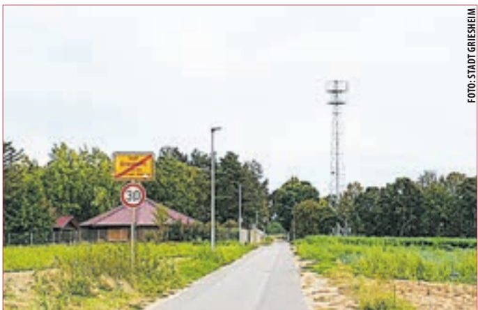
NEUER MOBILFUNKMAST im Griesheimer Südwesten.
