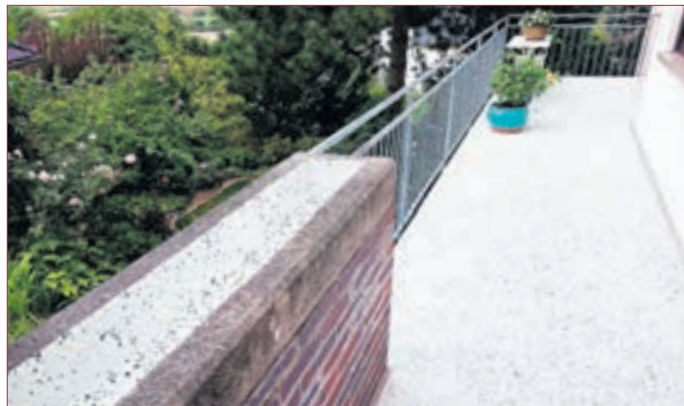
EIN TOP SANIERTER BALKON nach der bewährten Glanzner-Methode.
