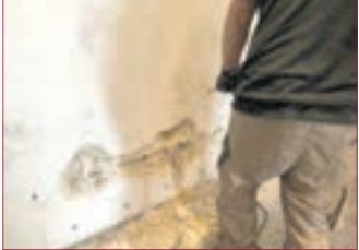
DIE VORBEREITUNG DER BOHR-LÖCHER: Sie werden ausgesaugt, dann erfolgt die Injektion.
