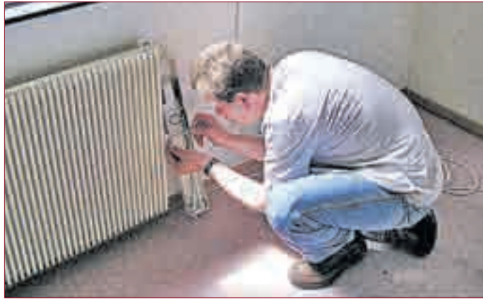
MONTAGE VOR ORT: Innerhalb eines Tages ohne Baustelle.
