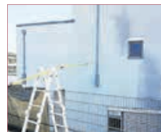
FASSADENHYDROPHOBIERUNG
