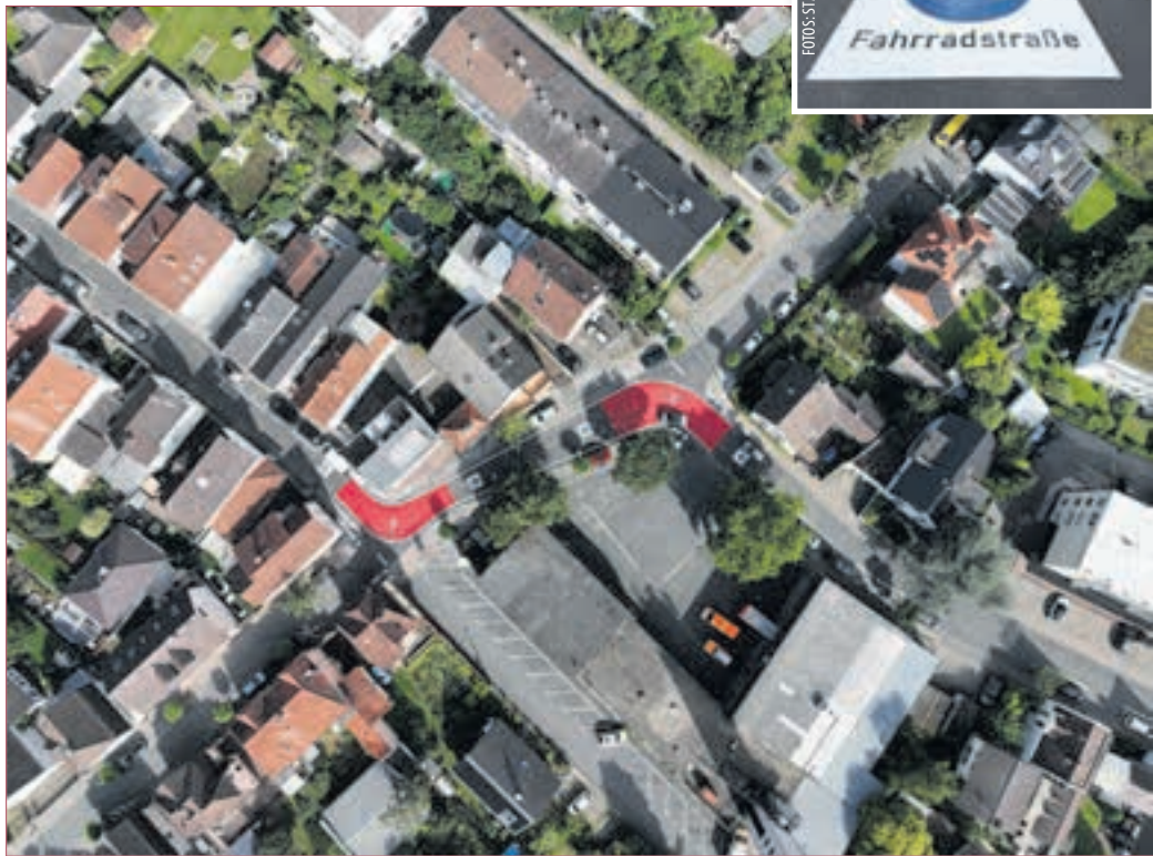
NACH VOLLSTÄNDIGER BESCHILDERUNG wird die Goethestraße und der umgebaute Teil der Darmstädter Straße zur fertigen Fahrradstraße.
