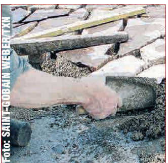
AUF DIE GRUNDLAGE KOMMT ES AN: Natur- oder Kunststeinplatten lassen sich mit dem richtigen Mörtel auch selbst verlegen. (txn-p)
