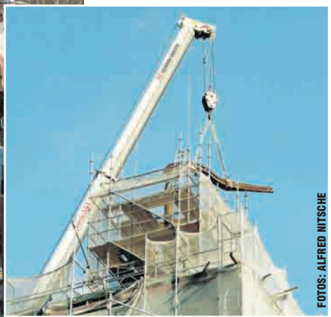
AUCH BALKEN des Turmdaches werden entfernt.
