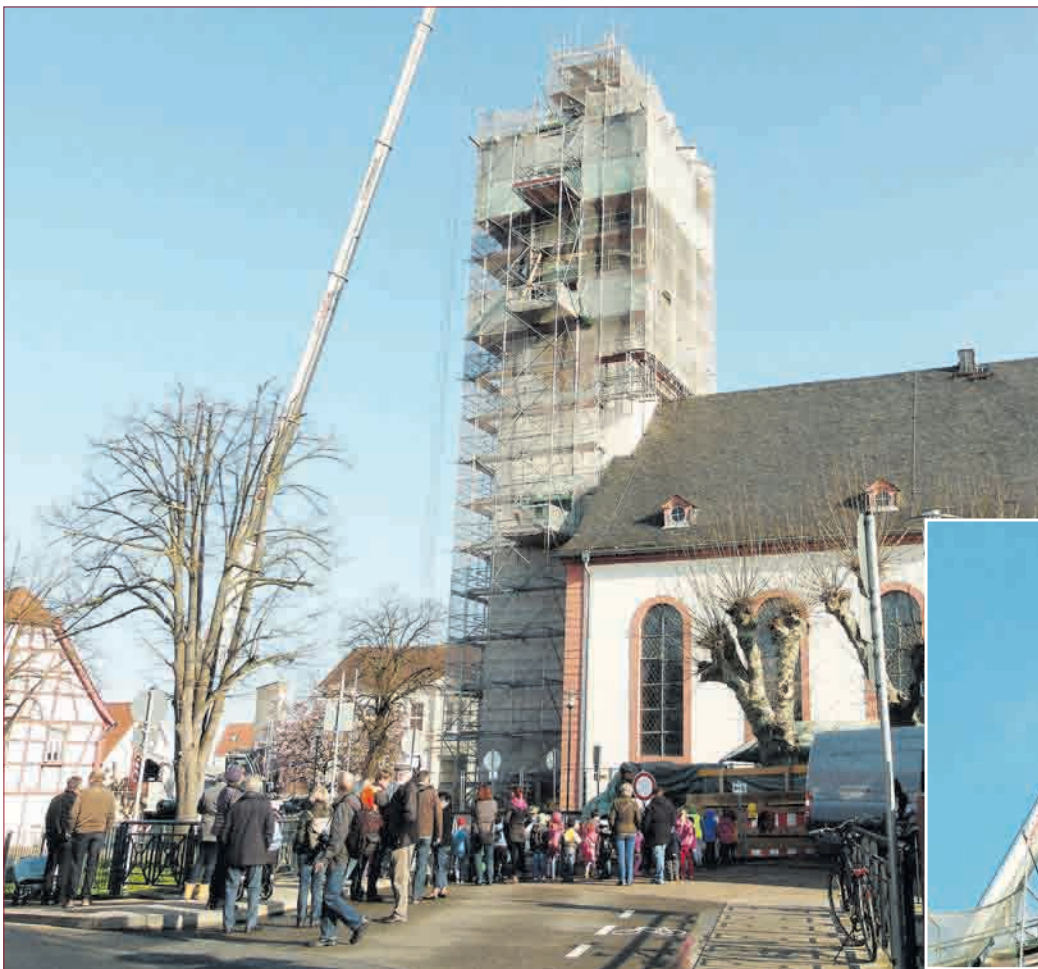
DER ALLES überragende Kran.
