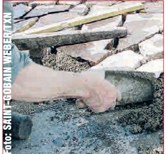
AUF DIE GRUNDLAGE KOMMT ES AN: Natur- oder Kunststoffplatten lassen sich mit dem richtigen Mörtel auch selbst verlegen. (tzn-p)
