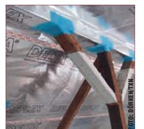
**LUFTDICHTIGKEIT** ist eine der wichtigsten Voraussetzungen für ein dauerhaft wärmedämmendes, funktionssicheres Dach. (txn-p)
