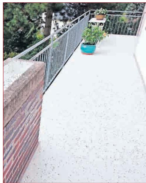
TOP SANIERTER BALKON nach Glanzner-Methode.
