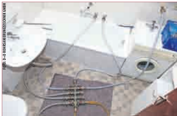
VERNETZTES SYSTEM: D+D stellt ein vernetztes System der Wasserleitungen her und saniert dann in drei Schritten: trocknen, strahlen und beschichten. Und das Ganze auch über mehrere Geschosse.
