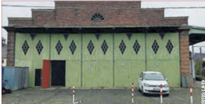
FRÜHERE WAGENHALLE der Straßenbahn in Darmstadt-Griesheim, im Dezember 2019.
