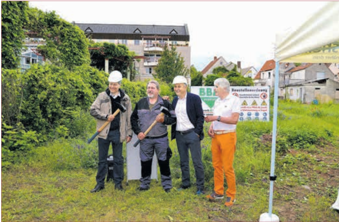
JETZT GEHT'S LOS! Bürgermeister Geza Krebs-Wetzl, Kay-Erik Otte von der beauftragten Abrissfirma BBM, Peter Biskupek und Ulrich Scheinert.
