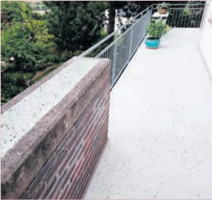
TOP SANIERTER BALKON nach Glanzner-Methode.
