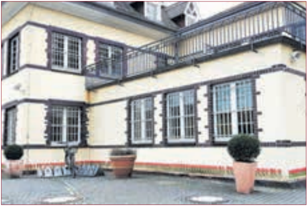
HORIZONTALSPERRE gegen aufsteigende Feuchtigkeit im Gebäude.
