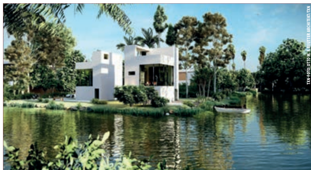
MIT EINER WOHN- UND NUTZFLÄCHE von fast 100 Quadratmetern bieten Mikro-Single-Häuser genug Platz für zum Wohnen auf winzigen Grundstücken. Für Komfort und Energieeinsparung sorgt der Massivbaustoff Beton.
