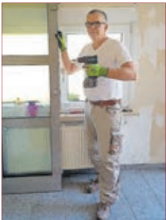
ALEXANDER RICHERT bei der Installation einer Tür.
