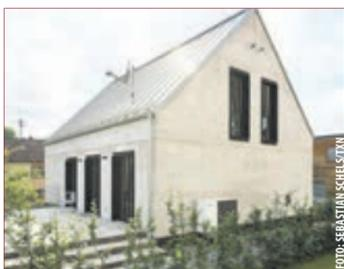
KEIN PUTZ, KEINE FASSADENDÄMMUNG: Mit Infraleichtbeton lassen sich die Außenwände eines Eigenheims auf das Wesentliche reduzieren. Der hochbelastbare monolithische Baustoff schützt vor Kälte, Schall und Feuer. Infraleichtbeton setzt jedoch nicht nur in punkto Bau- und Wohnkomfort neue Maßstäbe, sondern ist auch ökologisch empfehlenswert: der Hochleistungsbeton kann vollständig recycelt werden. (tbn)
