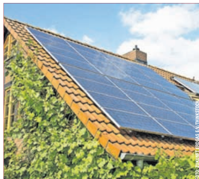
BRENNWERTKESSEL sind so effizient, dass sie auch in Altbauten nicht ausgetauscht werden müssen. Clevere Hausbesitzer nutzen Solarenergie zur Unterstützung
