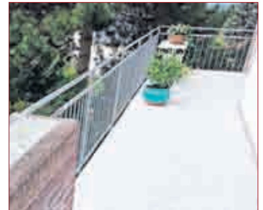
TOP SANIERTER BALKON nach Glanzner-Methode.
