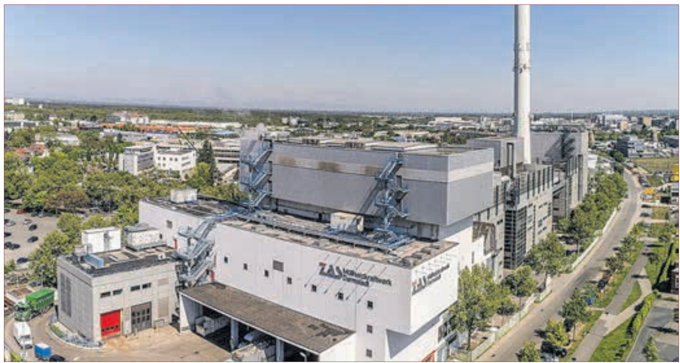
MÜLLHEIZKRAFTWERK (MHKW) Darmstadt
