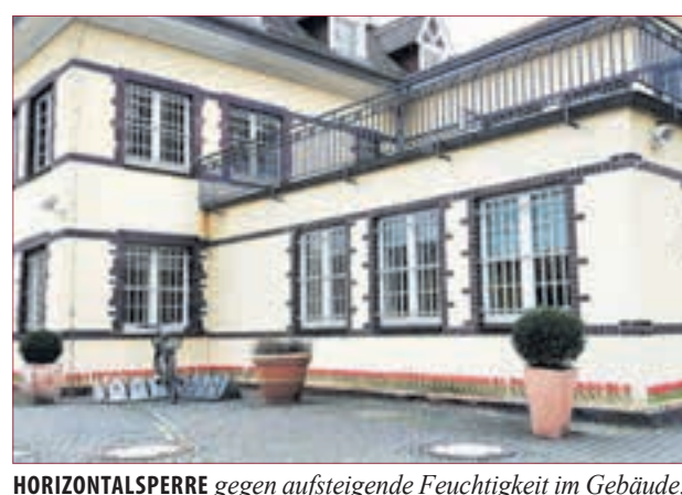
HORIZONTALSPERRE gegen aufsteigende Feuchtigkeit im Gebäude.
