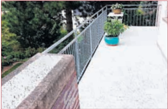
TOP SANIERTER BALKON nach Glanzner-Methode.
