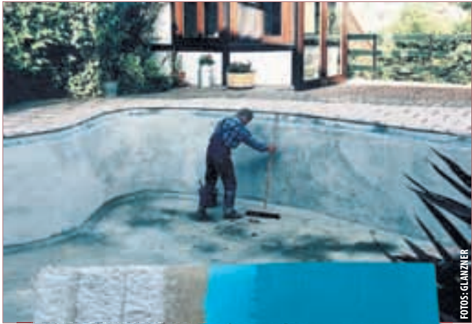
1-3 Glasfasermatten getränkt mit Harz, 4 Vorversiegelung, 5 Endversiegelung in allen RAL-Farben
