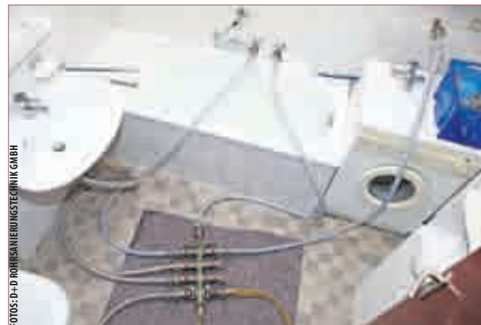
DAS D+D VERFAHREN wird an die Wasserleitung angeschlossen – ohne die Wände aufzustemmen werden die Rohre saniert.
