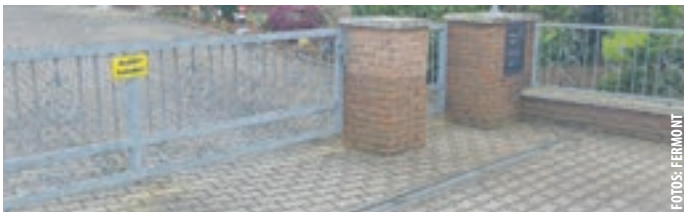
ZAUNANLAGEN und Geländer sowie Metallbau...
