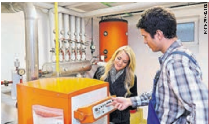
ANSPRUCHSVOLLES HANDWERK MIT PERSPEKTIVE: Fachleute der Sanitär-, Heizungs- und Klimatechnik sind mit der neuesten Technik vertraut - vor allem was die intelligente Vernetzung zwischen Haus und Heizungssystemen betrifft. (tzn)
