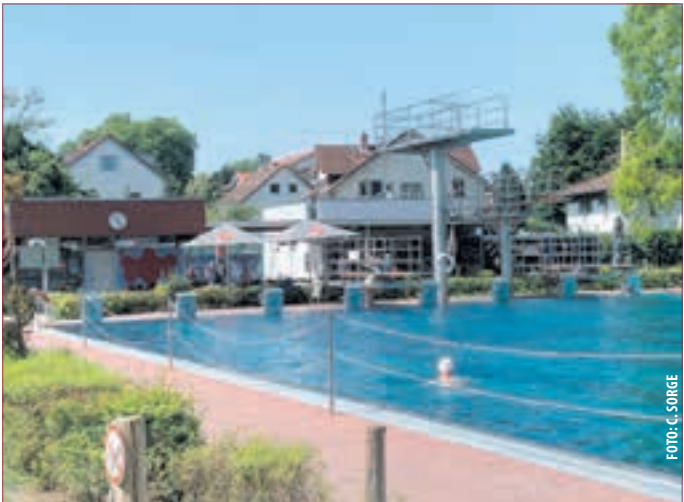
BLICK RICHTUNG SÜDWEST, zu sehen ist der Sprungturm und Kiosk.
