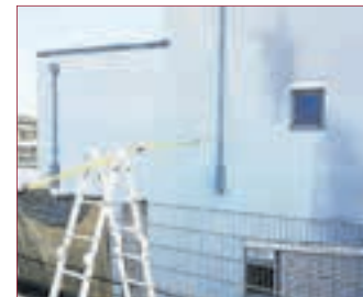
FASSADENHYDROPHOBIERUNG
