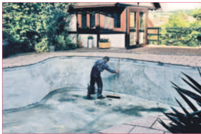
GRÜNDLICHE VORBEREITUNGEN zur Abdichtung werden vorgenommen
