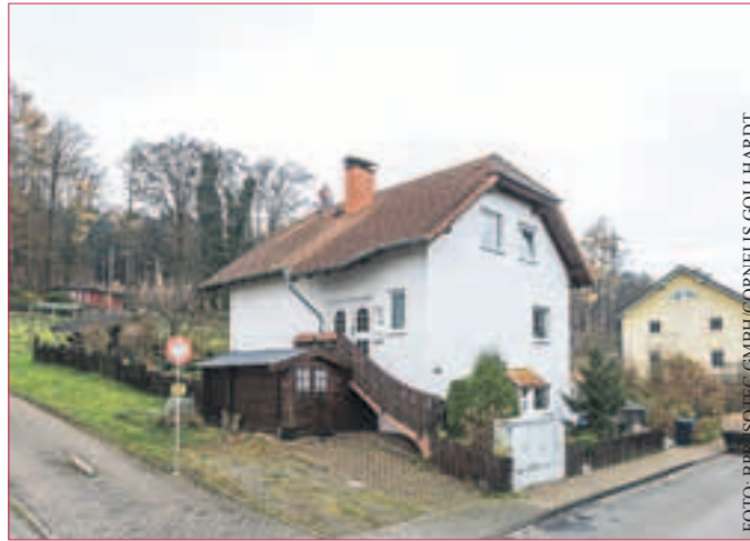
HAUS VON FAMILIE SPANEL: Abdichtungen und Feuchteschutz sind keine Nebensache, sondern wesentlich für den Werterhalt und für gesundes Wohnen.
