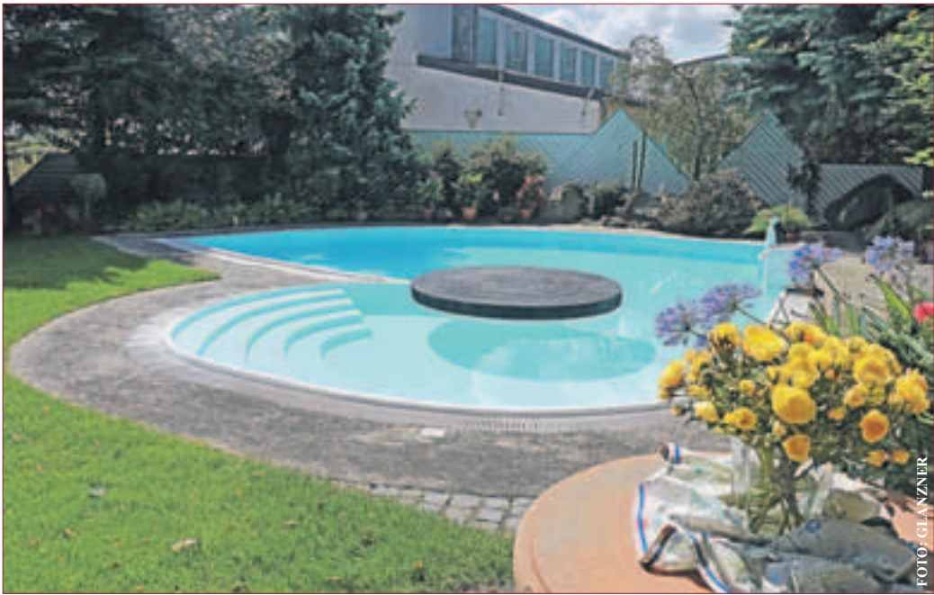
Das beschichtete Becken ist nun dicht.
