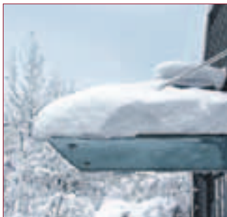
links: Vordächer müssen so konzipiert und befestigt sein, dass sie auch schwere Schneelasten tragen. rechts: Echtglas-Vordächer im Test.
