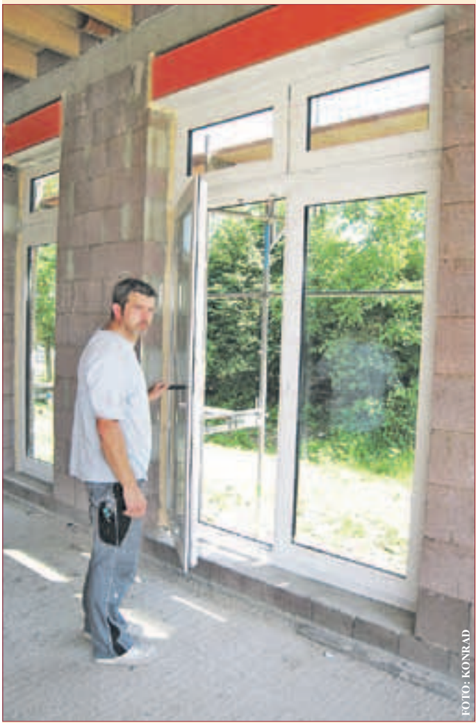
Viel Sorgfalt ist gefordert: Ein Mitarbeiter von Fensterkompetenz Konrad GmbH beim Einbau eines Energiesparfensters.
