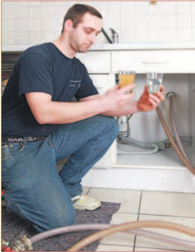
Nach der Sanierung – die Proben zeigen deutlich den Unterschied.
