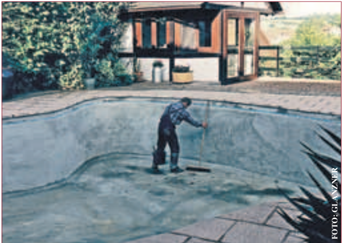
Die GFK-Beschichtung wird nach der Vorbereitung des Untergrundes aufgebracht.
