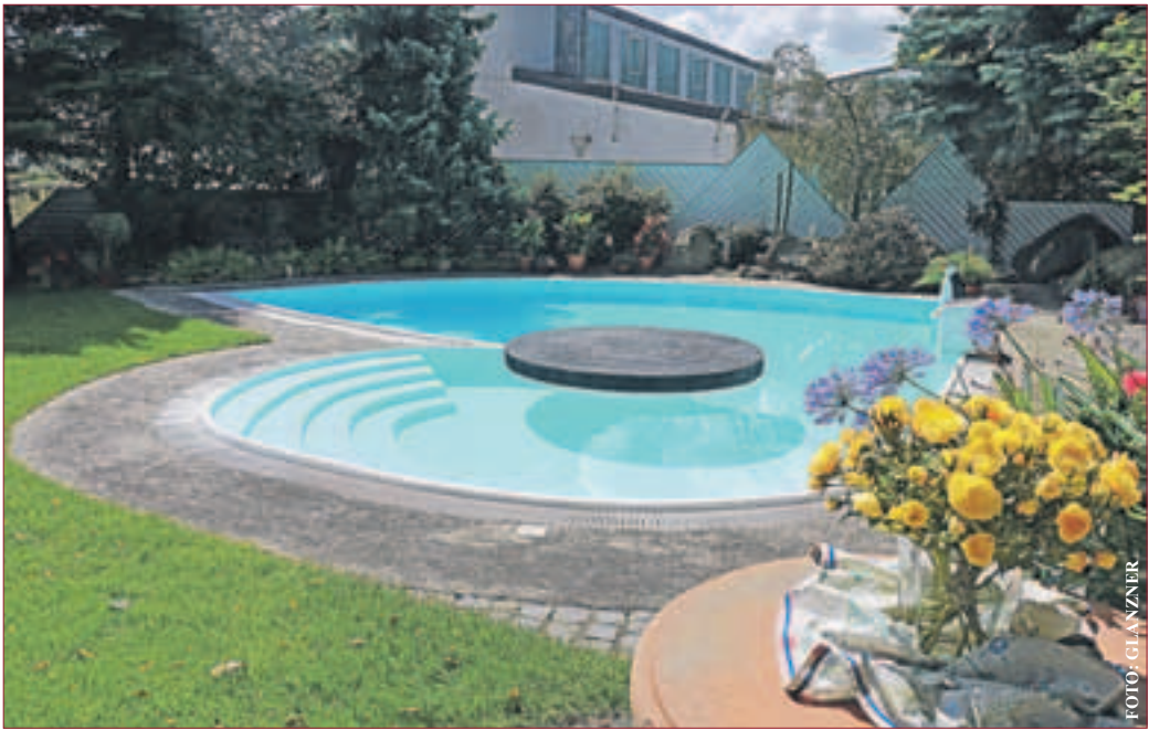
Das beschichtete Becken ist nun dicht.
