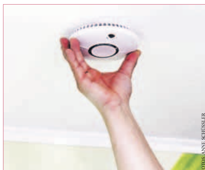
NACHRÜSTUNG ERFORDERLICH: Seit 2005 müssen Neubauten in Hessen mit Rauchmeldern versehen werden. Bis 2014 muss der Bestand an den Wohnungen nachgerüstet sein. Für das Anbringen eines Rauchmelders braucht Ralf Schad nur wenige Minuten und braucht nicht zu bohren.
