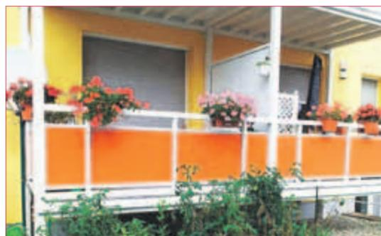
VORSTELLBALKON aus Aluminium. Viele Konstruktionen aus Holz werden im Laufe der Zeit morsch. Balkone können kostengünstig aus Aluminium angebaut werden.
