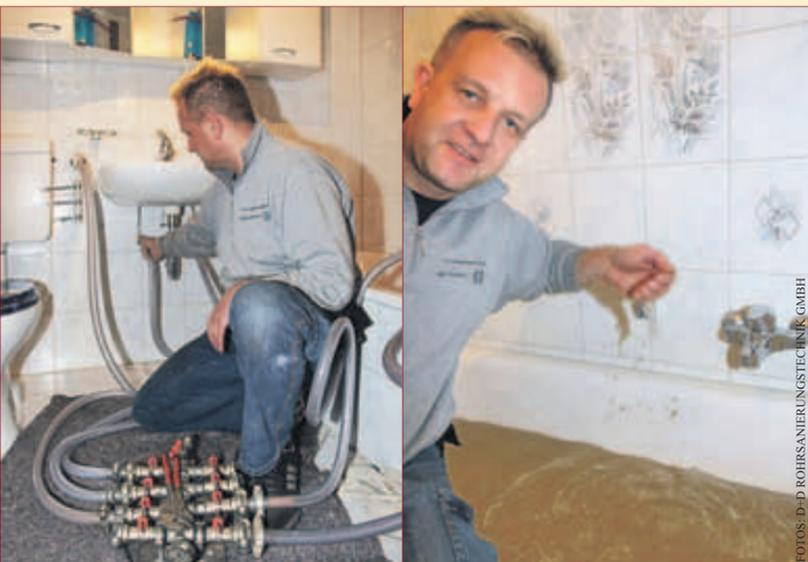
D+D Fachleute nehmen vor der Sanierung den Zustand der Wasserleitungen in Augenschein.
